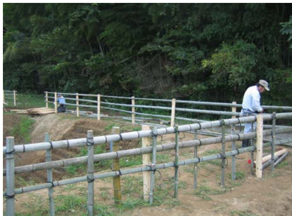
安全施設(竹垣)設置作業状況
