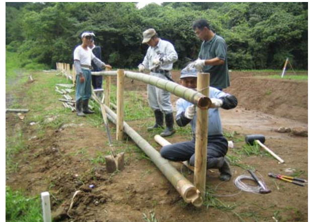
安全施設(竹垣)設置作業状況
